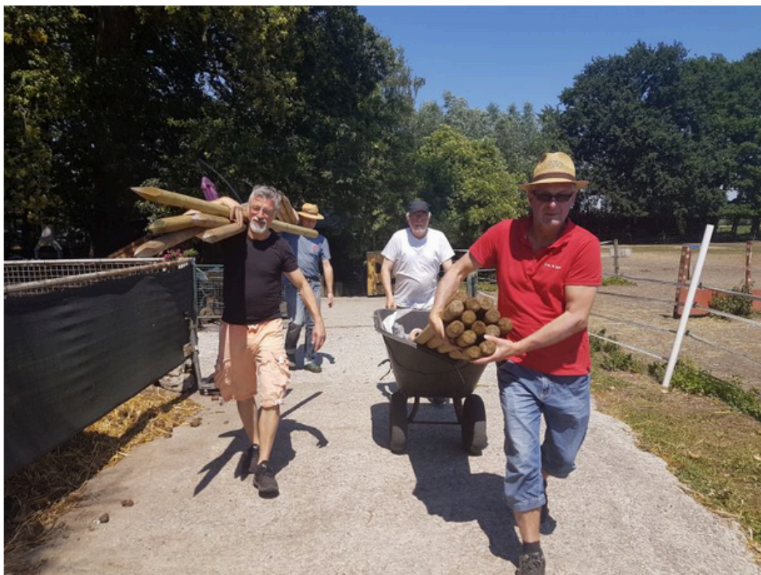
Mit vereinten Kräften haben Helfer der Stiftung „Live to Love – Germany“ auf dem Gelände des Mastholter Gnadenschutzhofs „Sol Luna“ eine Koppel umzäunt. Darin können künftig die Pferde der Einrichtung Auslauf genießen. Bild: Live to Love
